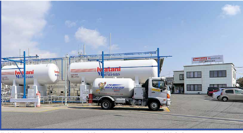
集合住宅などに設置されるバルク貯槽に、バルクローリー車から直接充填できるLPガス供給システムを採用
