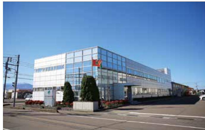
本社・北陸支店外観
