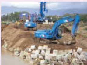
長野市穂保地区の堤防復旧工事
